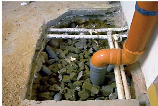
Figura 4.3. Scavo di un pozzetto radon [13]
