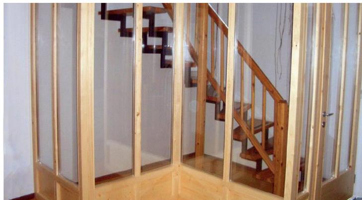
**Figura 4.4.** *Isolamento con rivestimento ermetico della scala d’accesso alla cantina [13]*
