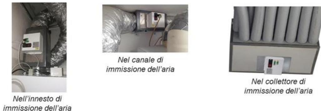
**Figura 1.57.** Opzioni di installazione di ionizzatori NTP [39]
