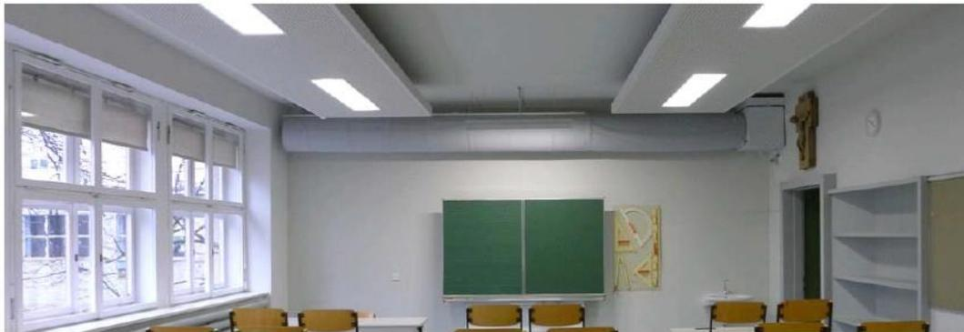
**Figura 1.72.** Diffusore dell'aria in tessuto perforato con silenziatore e ventilatore [128]
