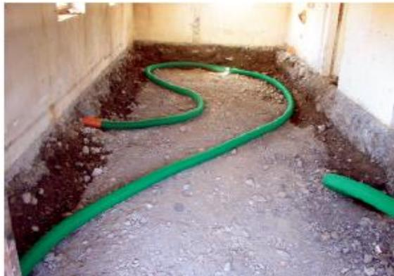
**Figura 4.5.** *Installazione di un sistema di drenaggio radon con rifacimento della sottostruttura del pavimento [13]*
